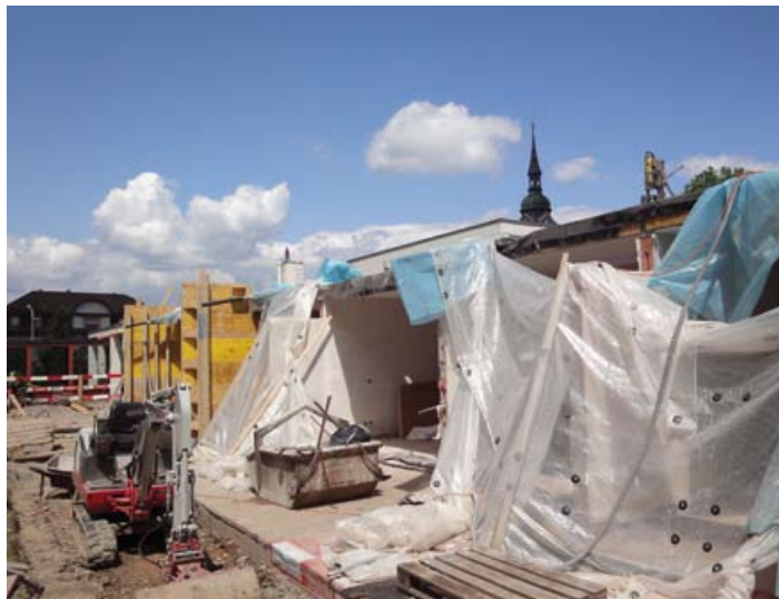
Die Baustelle während den Umbauarbeiten.
